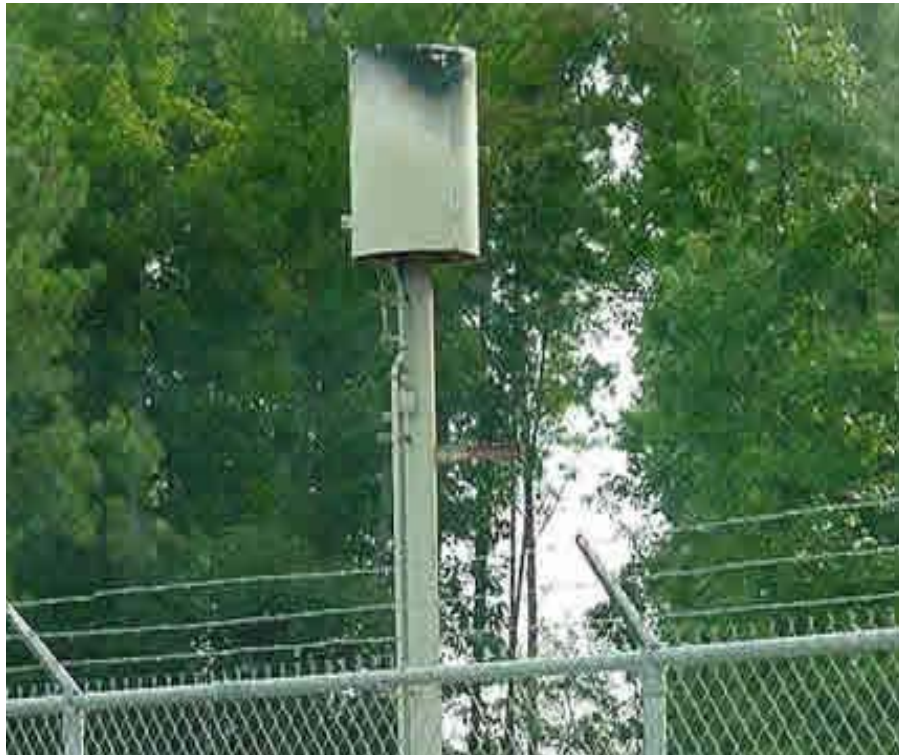
Figura 31 - Flare utilizado para queimar o gás do aterro. Fonte: FREUDENRICH (2007)
