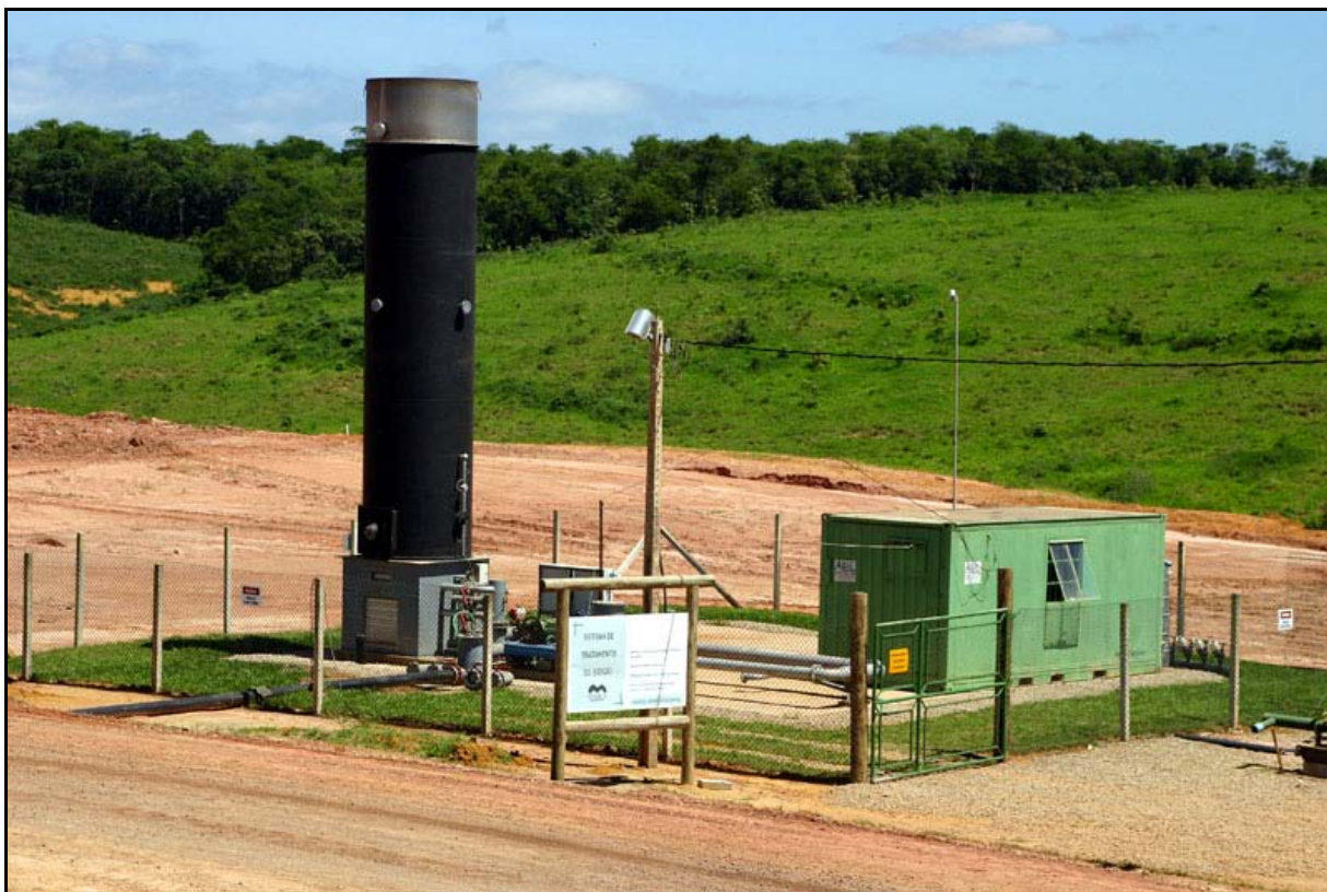
Figura 41 - Flare implementado na CTR Marca Ambiental Fonte: Foto enviada pela Marca Ambiental
