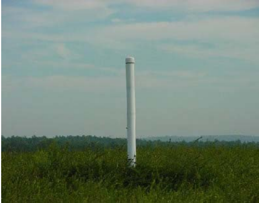
Figura 30 - Um tubo coletor de metano ajuda a coletar o gás do aterro. Fonte: FREUDENRICH (2007)
