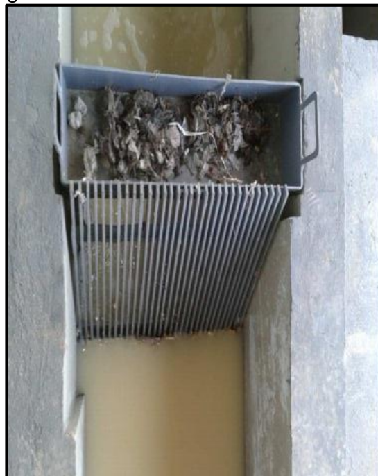
Foto 10 – Retenção de sólidos no gradeamento
