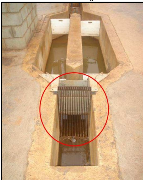
Foto 09 – Processo de gradeamento
